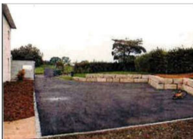
Asphaltbelag und Stützmauern
